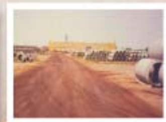
CANTIERI - AREE DI STOCCAGGIO
